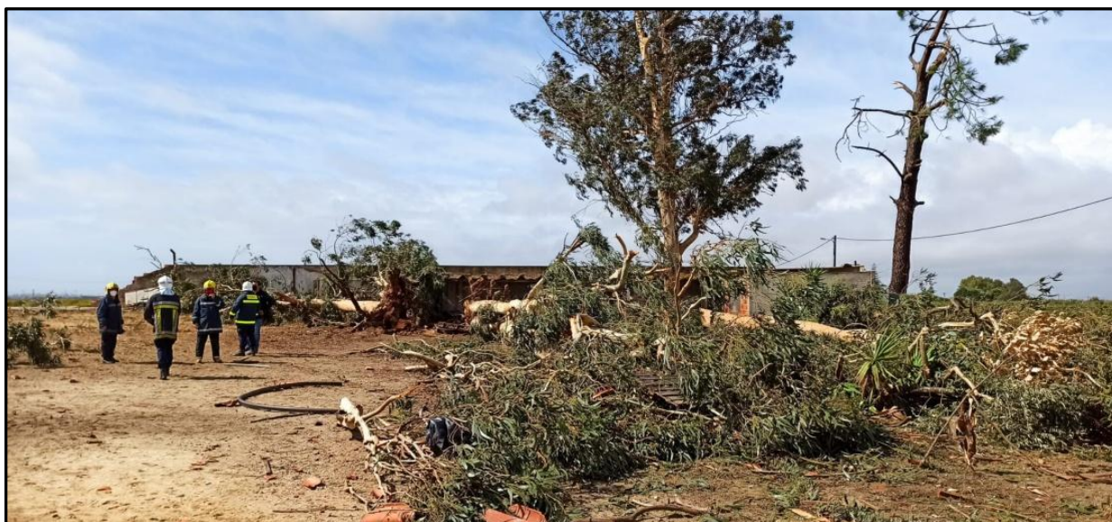
Figura A8 – Árvores de grande porte (eucaliptos) desenraizadas, partidas e/ou severamente danificadas (ponto T4).
