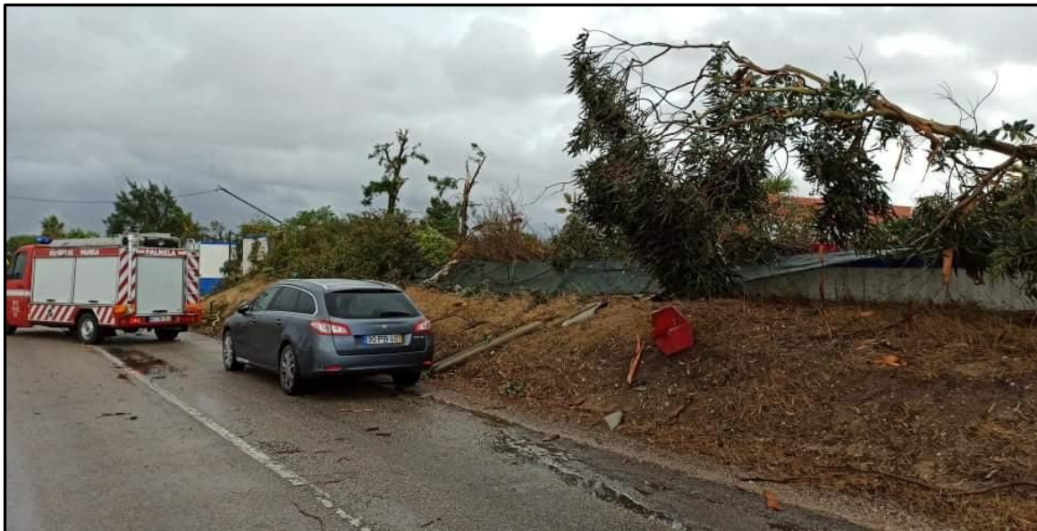
Figura A9 - Vedação confinante com a estrada derrubada numa larga extensão (ponto T4).
