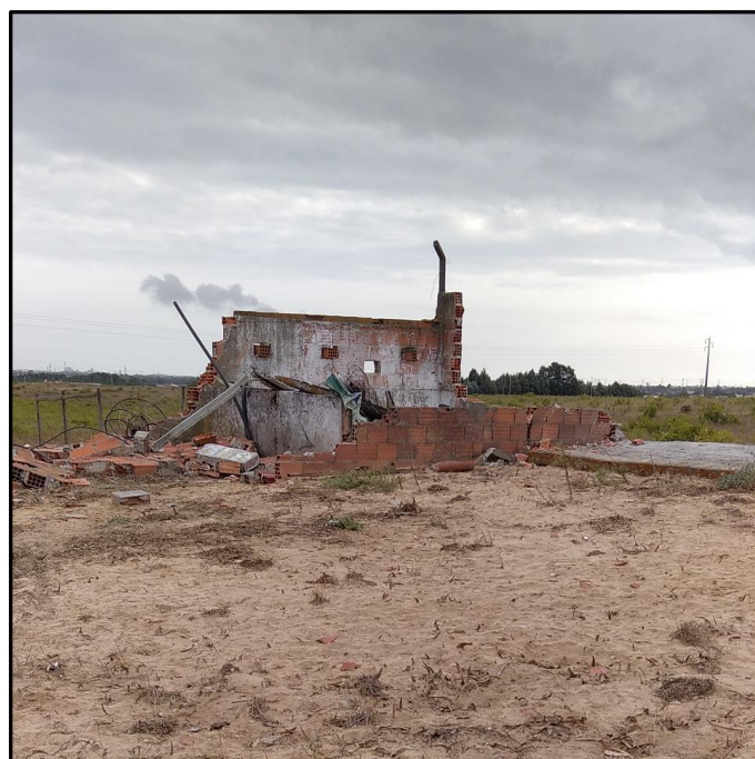
Figura A5 – Idem à Fig A4, noutro setor do muro (ponto T4).
