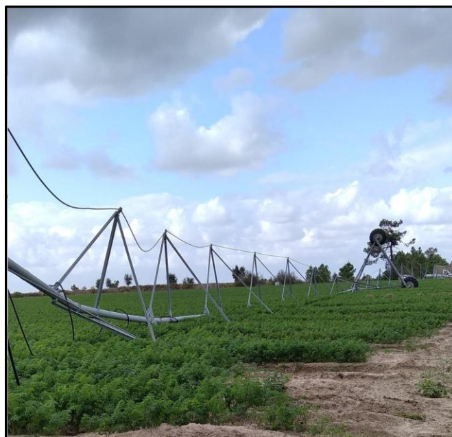
Figura A16 – Pivot e sistema de rega danificado, sob outra perspetiva (Ponto T5).
