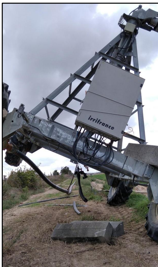
Figura A15 – Pivot de rega derrubado (Ponto T5).
