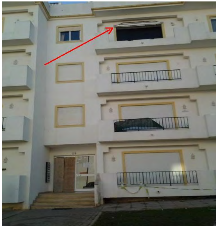
Fig E – Telhas completamente removidas, vedação arrancada pelos suportes (Ponto 3, Fig 1).
