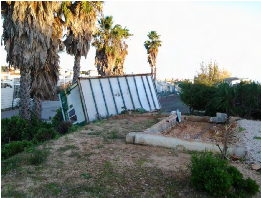
Fig C – Estrutura pré-fabricada deslocada e voltada (Ponto 2, Fig 1).
