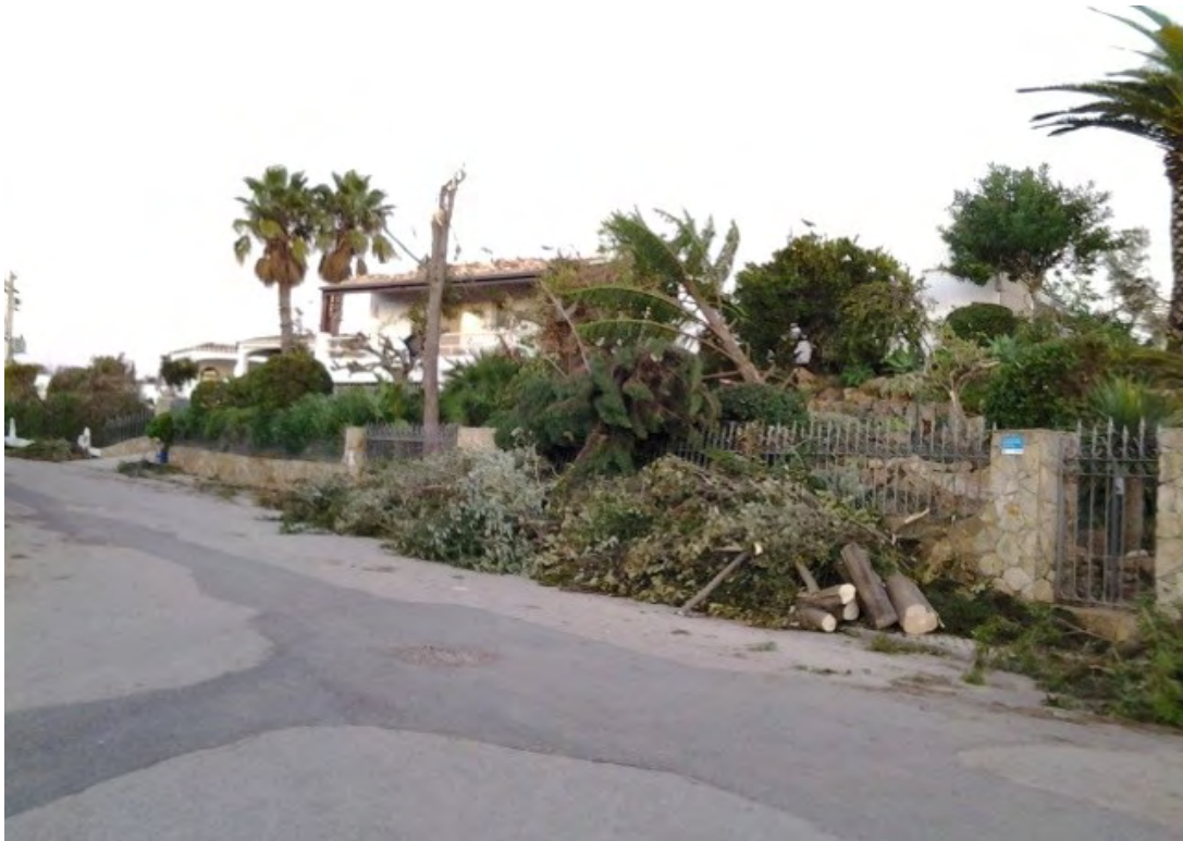
Fig A – Perspetiva da destruição em árvores; habitações, desprovidas de telhas, embora com placa (Ponto 1, Fig 1).
