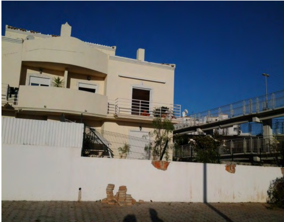
Fig E – Telhas completamente removidas, vedação arrancada pelos suportes (Ponto 3, Fig 1).
