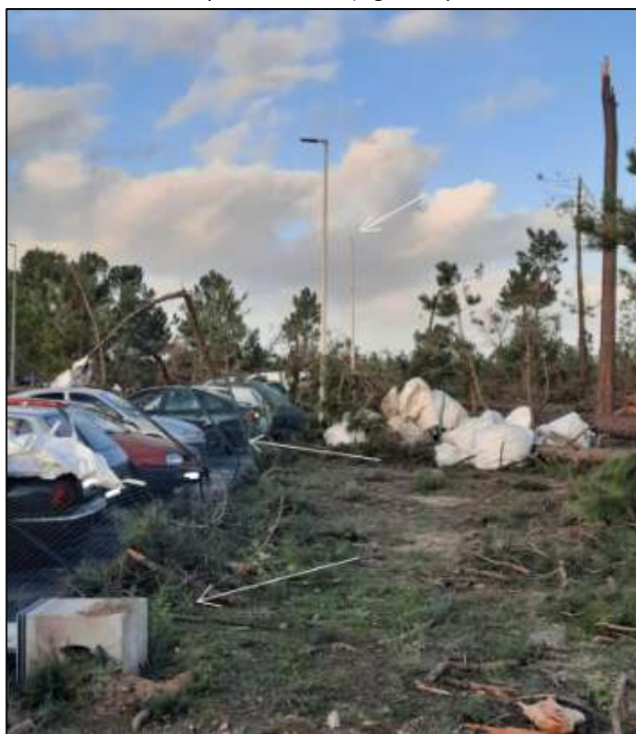
Figura A10 – Idem a Figura A9, noutra direção. Assinaladas: vedação destruída, poste de iluminação arrancado e poste de iluminação sem luminária (em último plano). Viaturas danificadas e destruição em árvores (Figura 6, ponto P3; fonte: Sr. Manuel Bolieiro).
