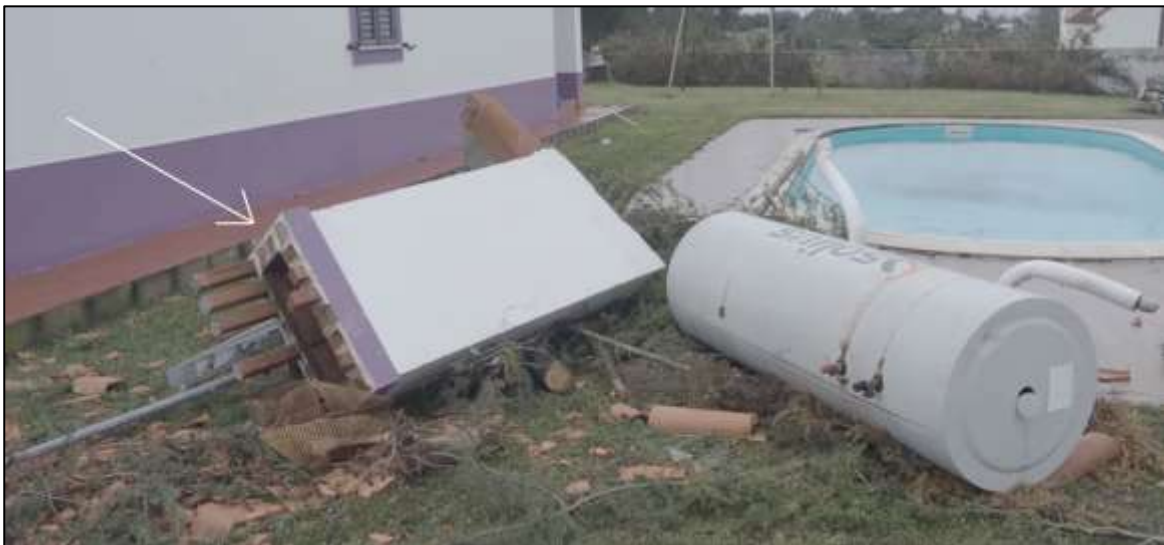
Figura A2– Assinalada chaminé arrancada ao telhado. Depósito de água de painéis solares arrancado (Figura 6, ponto P2; fonte: Sr. Manuel Bolieiro).
