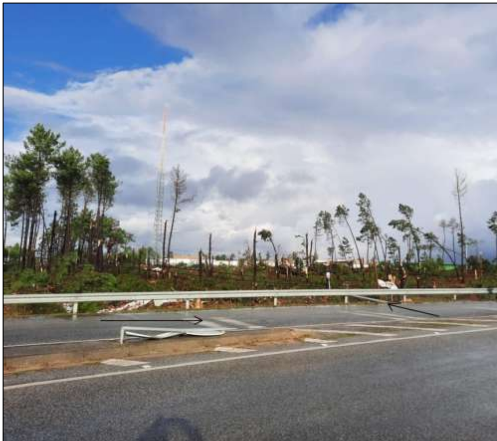
Figura A13 – Destruição em acesso à auto estrada A-13. Assinalado sinal de trânsito dobrado (da esquerda para a direita) e poste de iluminação arrancado (da direita para a esquerda), cujo pormenor se detalha na Figura A 12 (Figura 6, ponto P3; fonte: Sr. Manuel Bolieiro).
