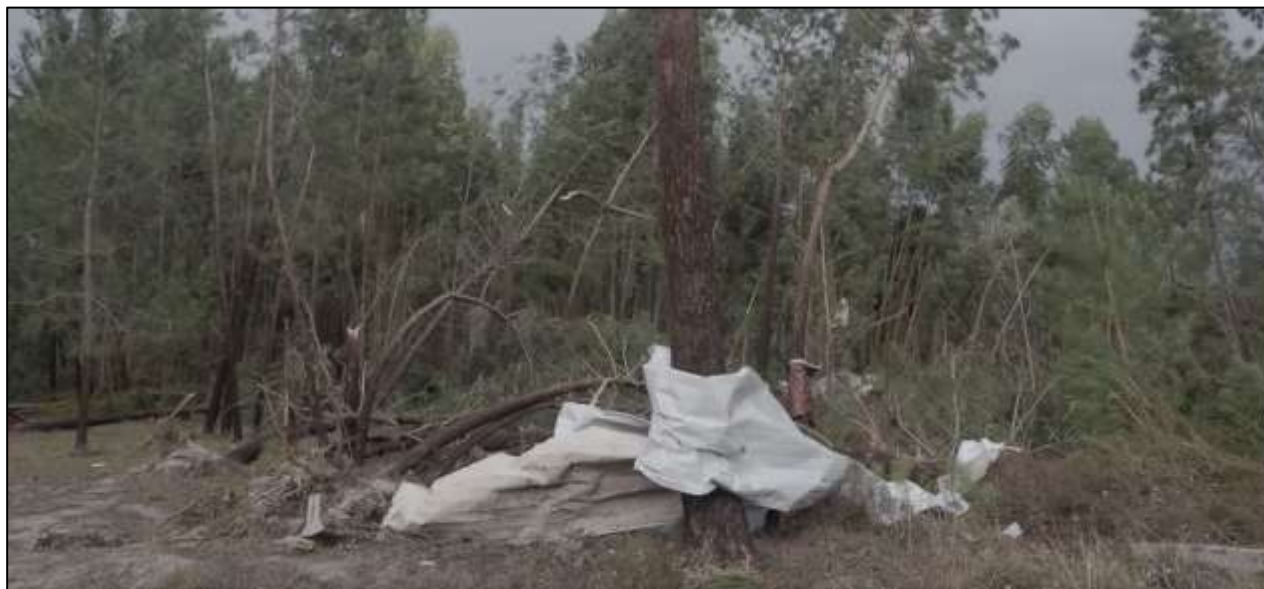
Figura A8 – Estrutura metálica arrancada noutra local e transportada pela circulação do tornado, projetando-se sobre uma árvore. Troncos dobrados e partidos (Figura 6, ponto P3, fonte: “Notícias do Sorraia”).
