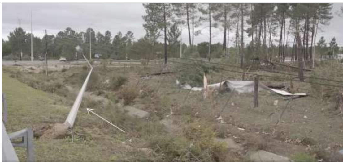
Figura A12 – Destruição em acesso à auto estrada A-13. Pormenor de poste de iluminação arrancado, igualmente assinalado na Fig A13 (noutro ângulo). Árvores decepada (Figura 6, ponto P3; fonte: “Notícias do Sorraia”).
