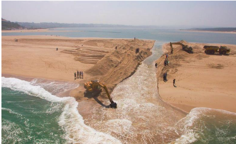
Figura 1 - Reabertura do canal que liga a Lagoa de Óbidos ao mar. (Fonte: Diário de Notícias/Lusa 18 maio, 2018).
