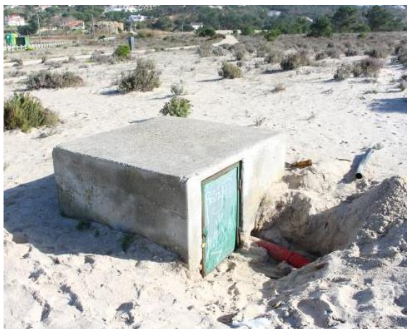
Figura 18 – Caixa e respetivo tubo de descarga diretamente na Lagoa.
